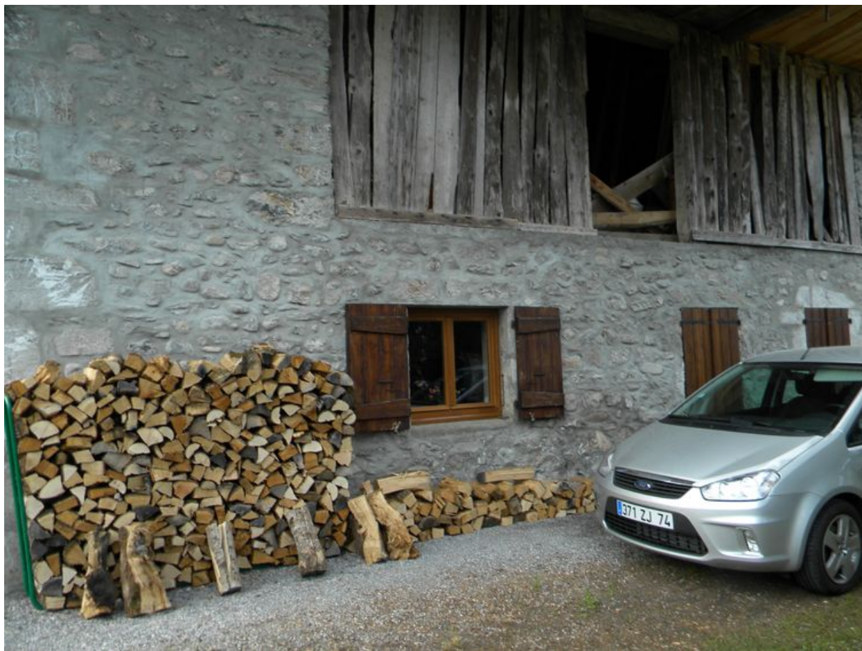
Vue partielle de la façade nord.
