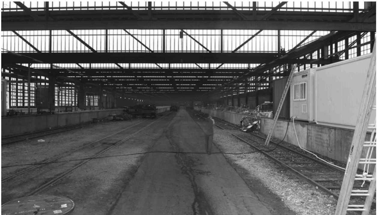
Raccordement ferroviaire sous les halles
