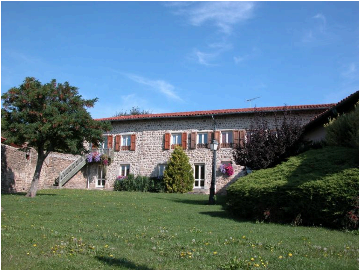
Bourg (le), C 10. Vue d'ensemble du presbytère.
