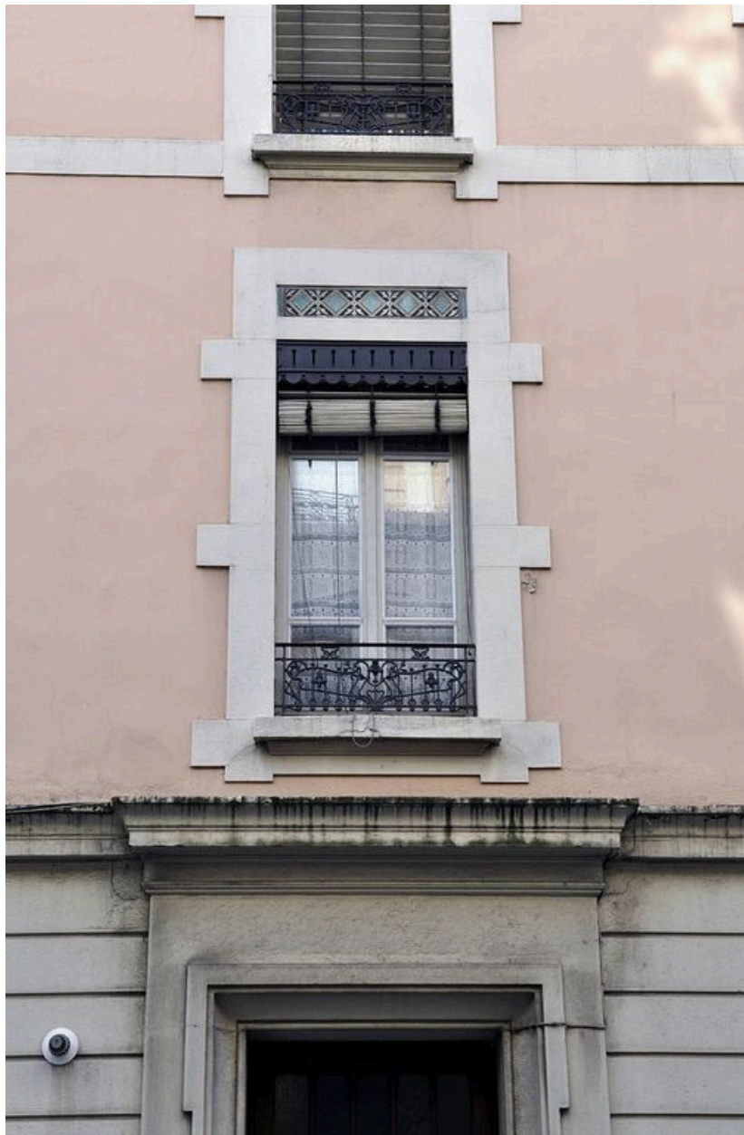
Façade antérieure, détail : baie du premier étage
