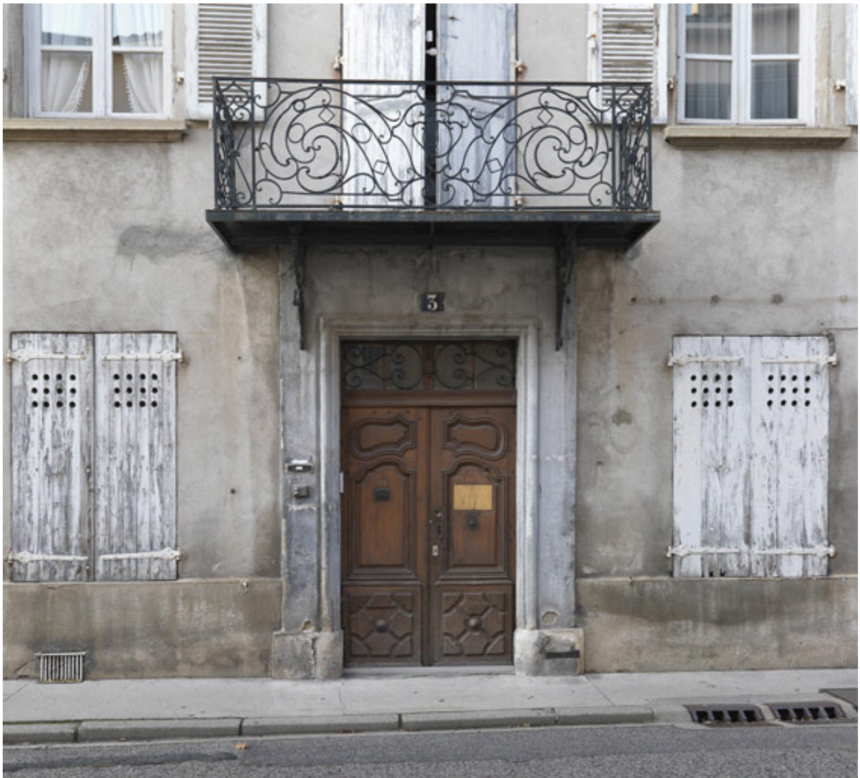
Porte bâtarde et balcon avec garde-corps en ferronnerie.
