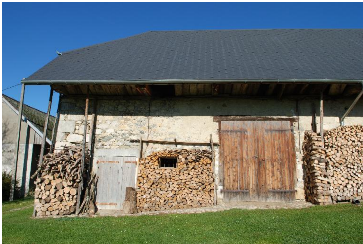
Vue partielle de la grange-étable, partie ouest.
