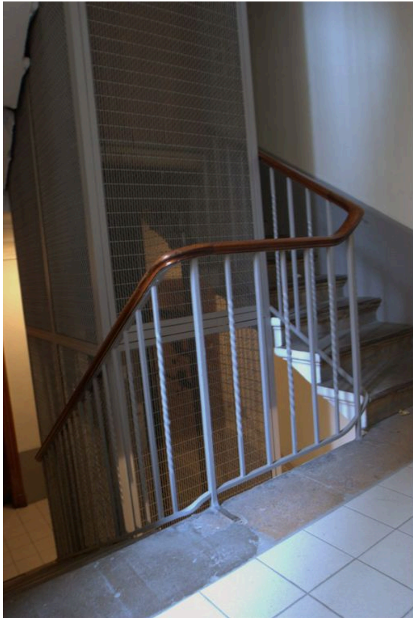
Vue de la rampe de l'escalier
