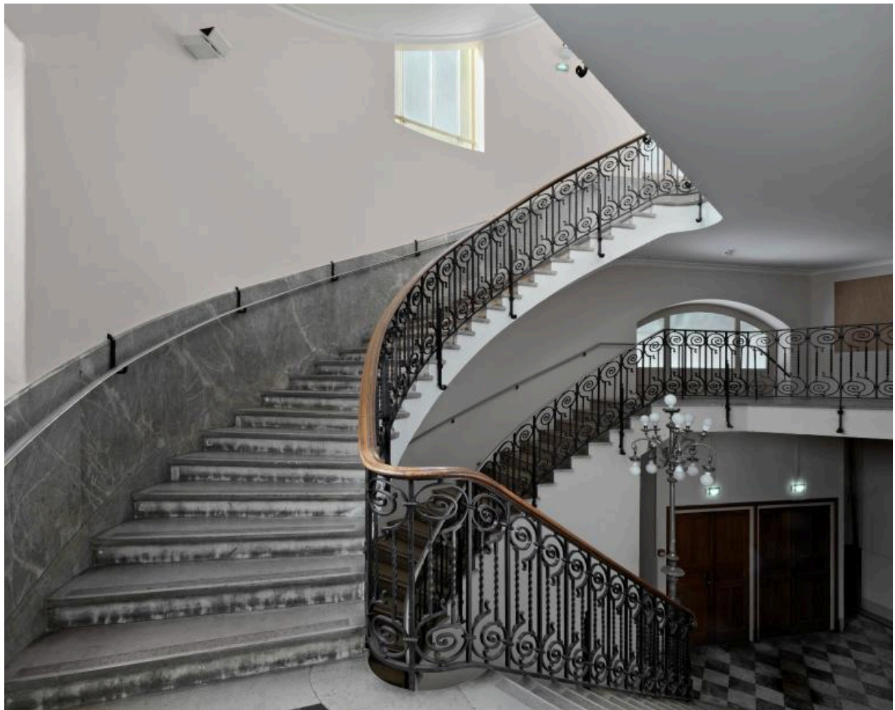
Salle Rameau : escalier B, vue générale
