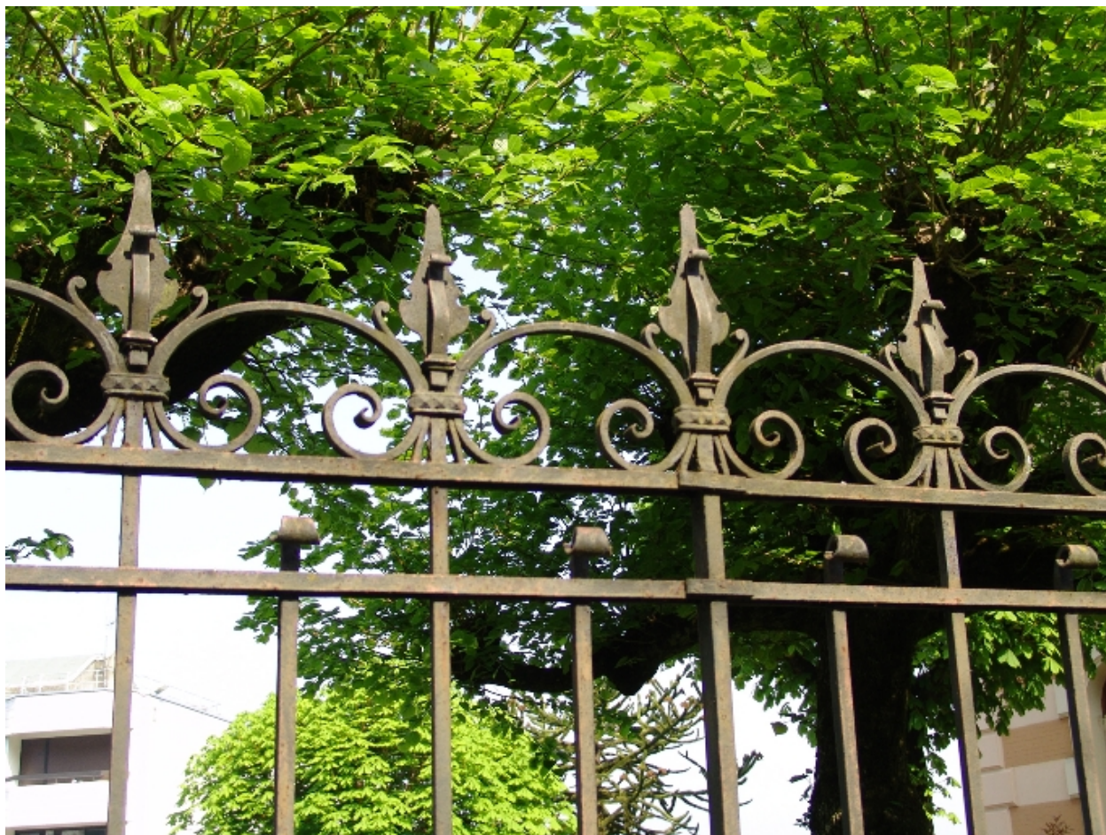
Détail de la grille bordant la rue
