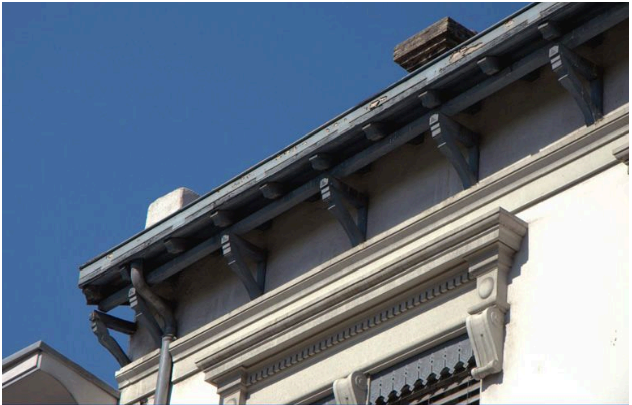
Elévation principale : détail de l'avant-toit
