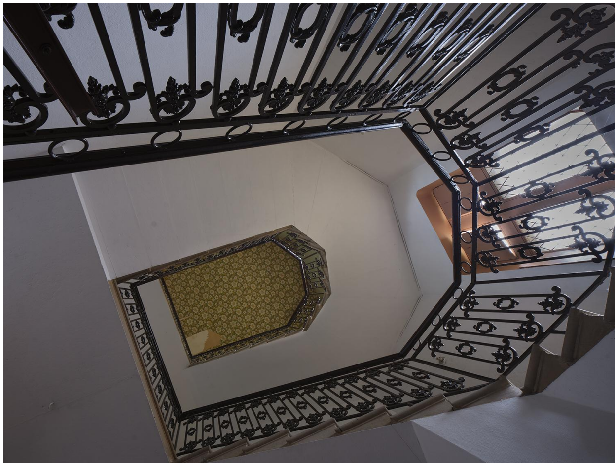
Château : escalier principal, vu depuis le bas
