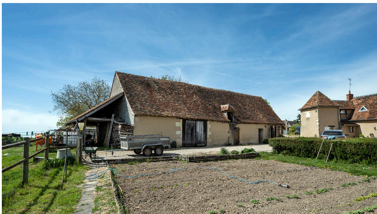
Vue générale de la grange
