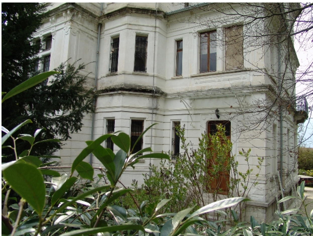
Détail de la façade postérieure
