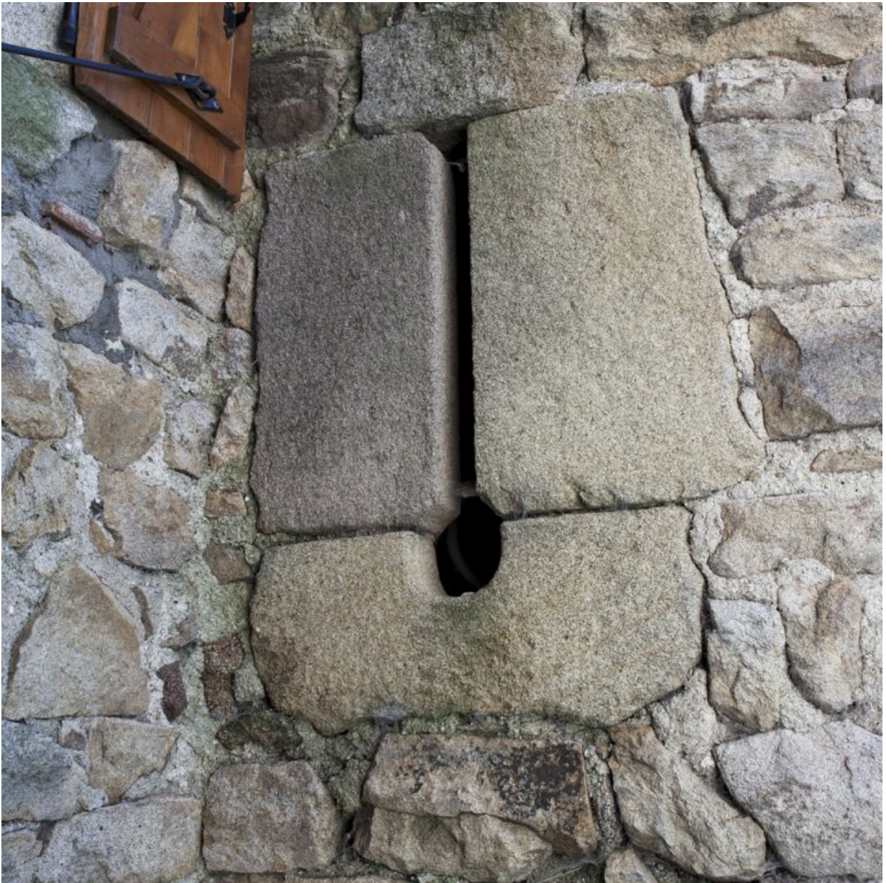
Archère-canonnaire située au sud de la base de la tour nord-est de la maison forte.
