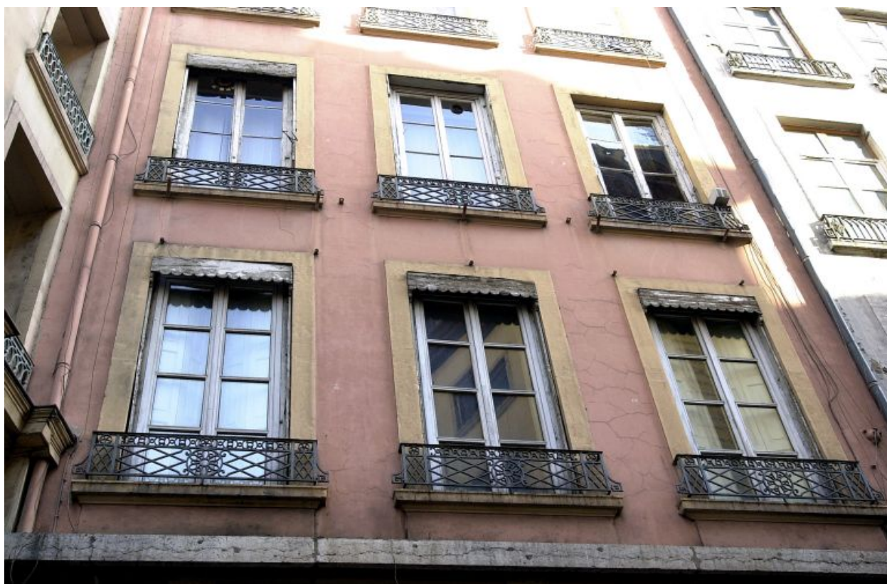
Façade principale, fenêtres du premier et deuxième étage
