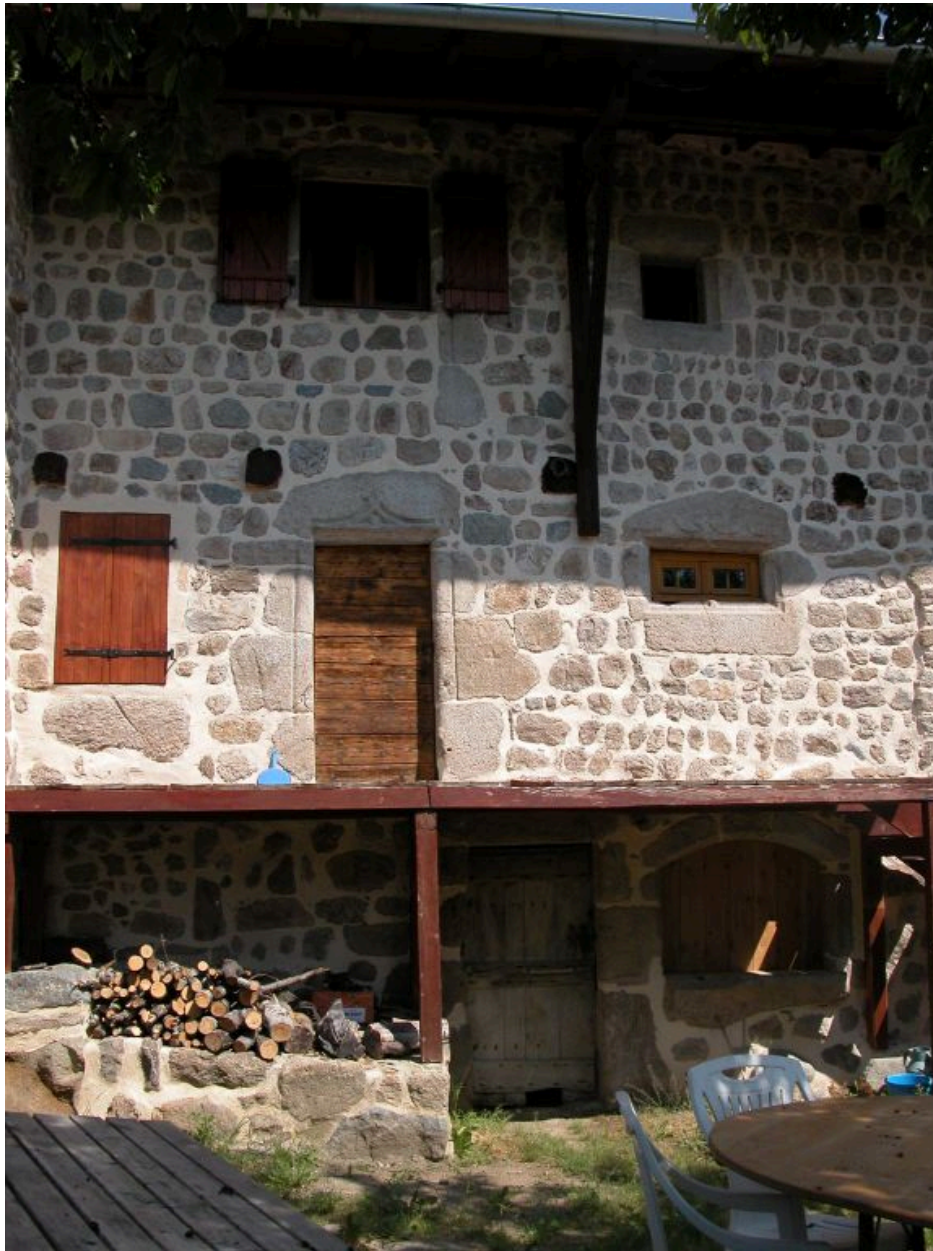
Vue d'ensemble de la façade du logis.
