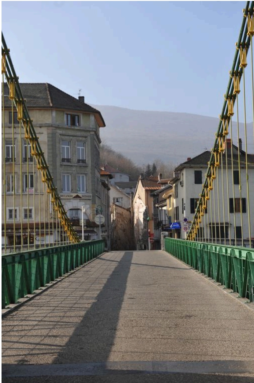
Vue partielle, travée droite et débouché du pont rive droite, de dessus (depuis le milieu du pont)
