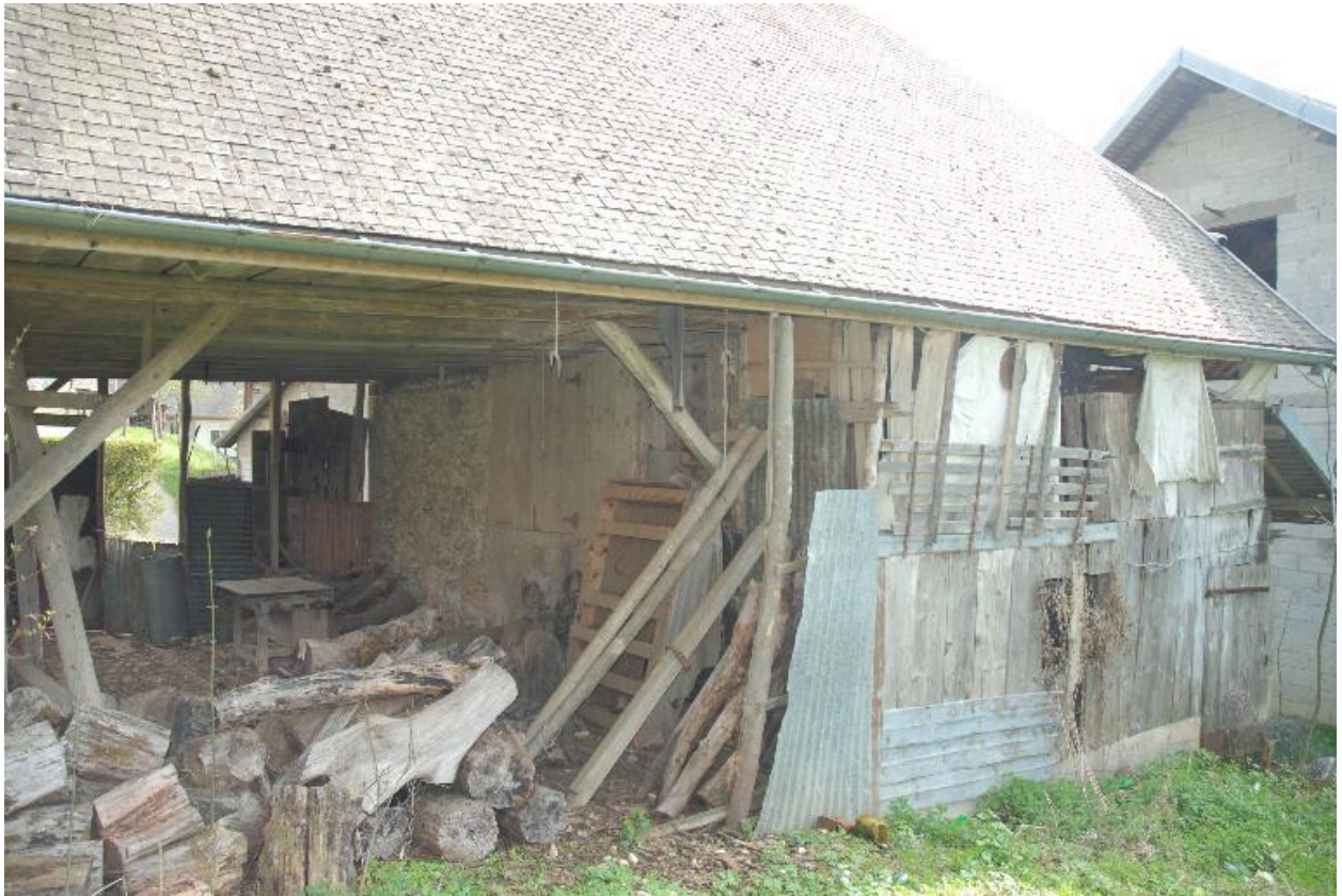
Vue arrière de la dépendance : bûcher.
