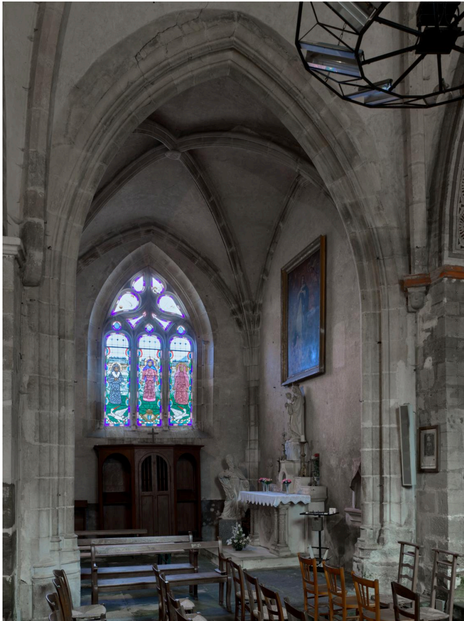
Vue de la chapelle de la Baume au nord-est de l'édifice.
