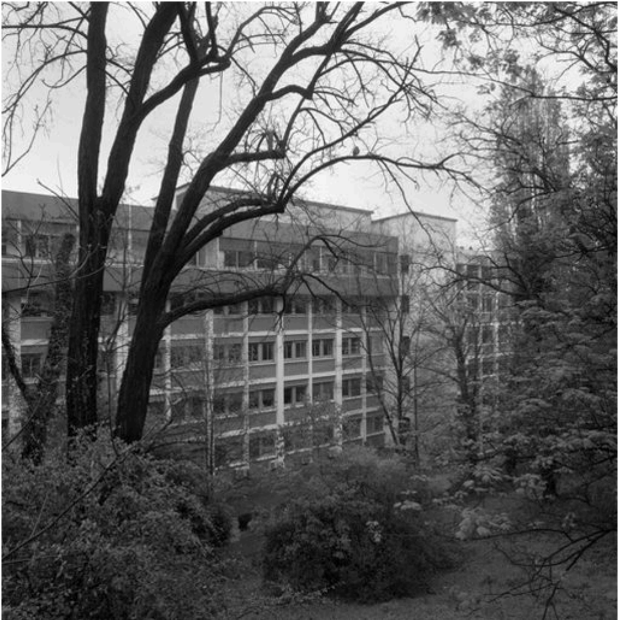
Bâtiment A, façade postérieure
