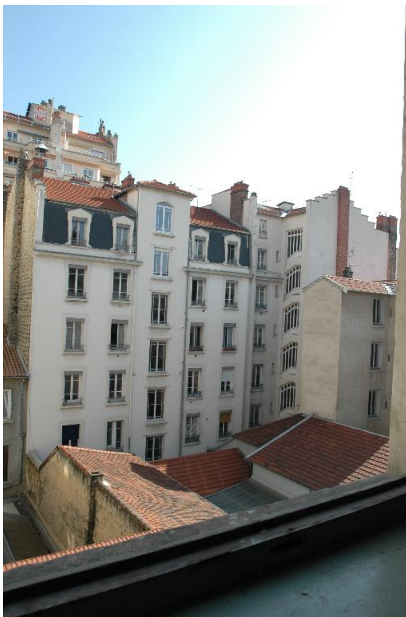
Vue générale des élévations postérieures
