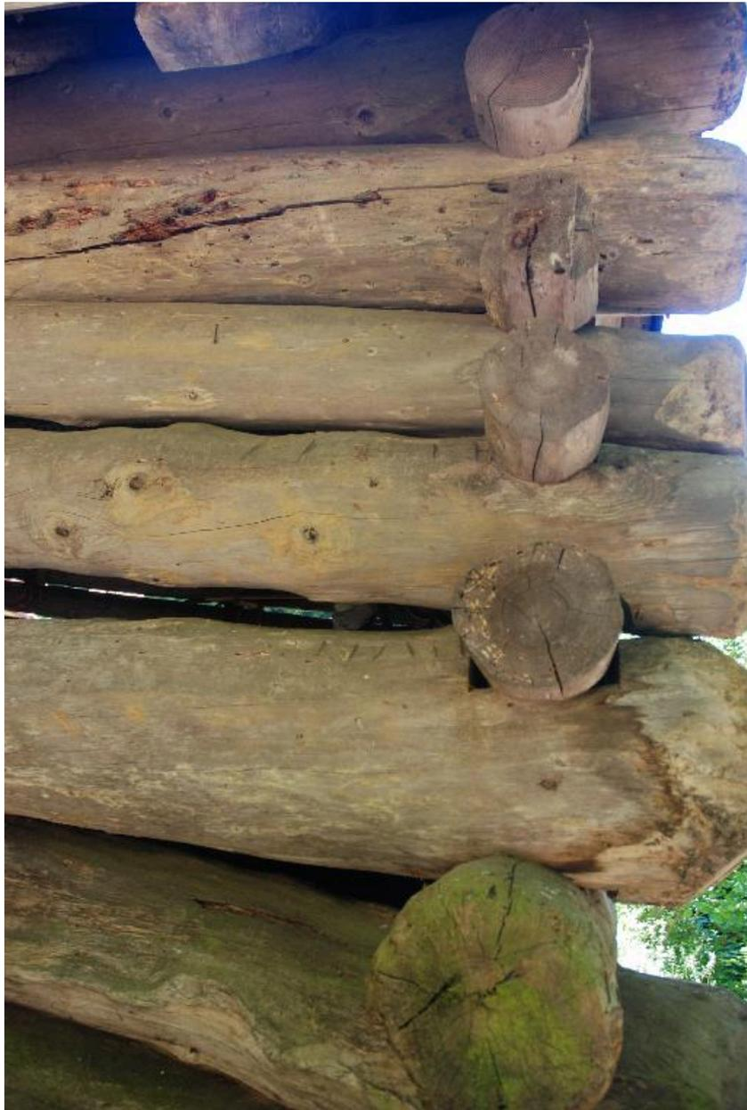
Détail de la grangette IA74002474, aux Prés de l'Auge : technique d'assemblage, marques entaillées dans les rondins.
