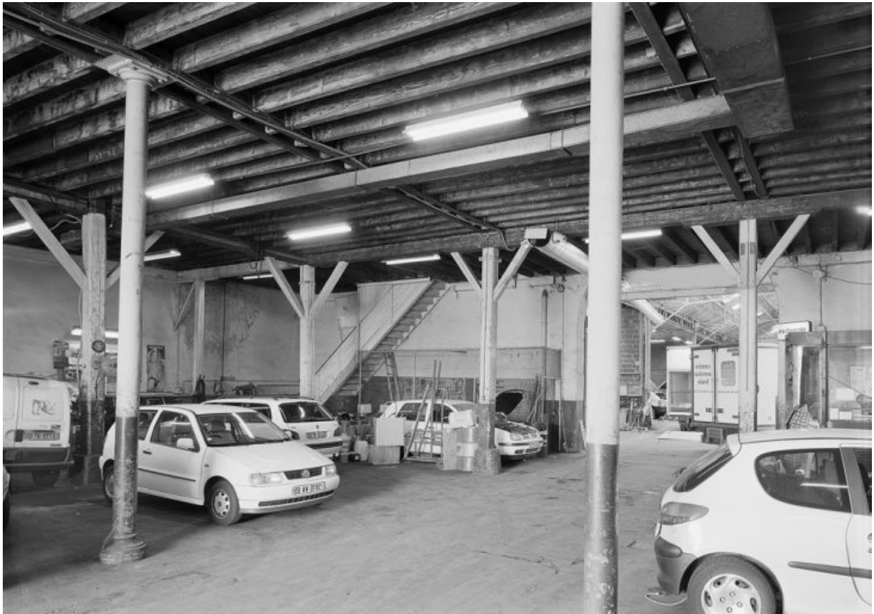
Vue d'ensemble du hangar quai Perrache
