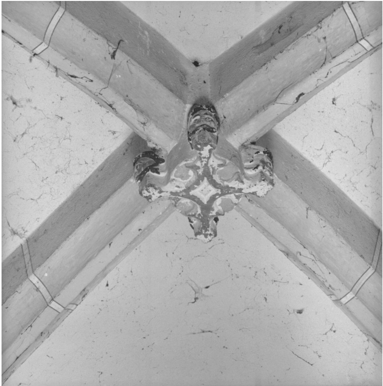
Détail de la clef de voûte de la 2e travée.
