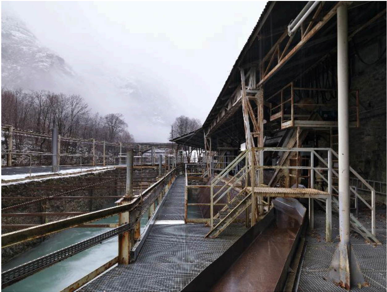
Vue amont du barrage de Livet
