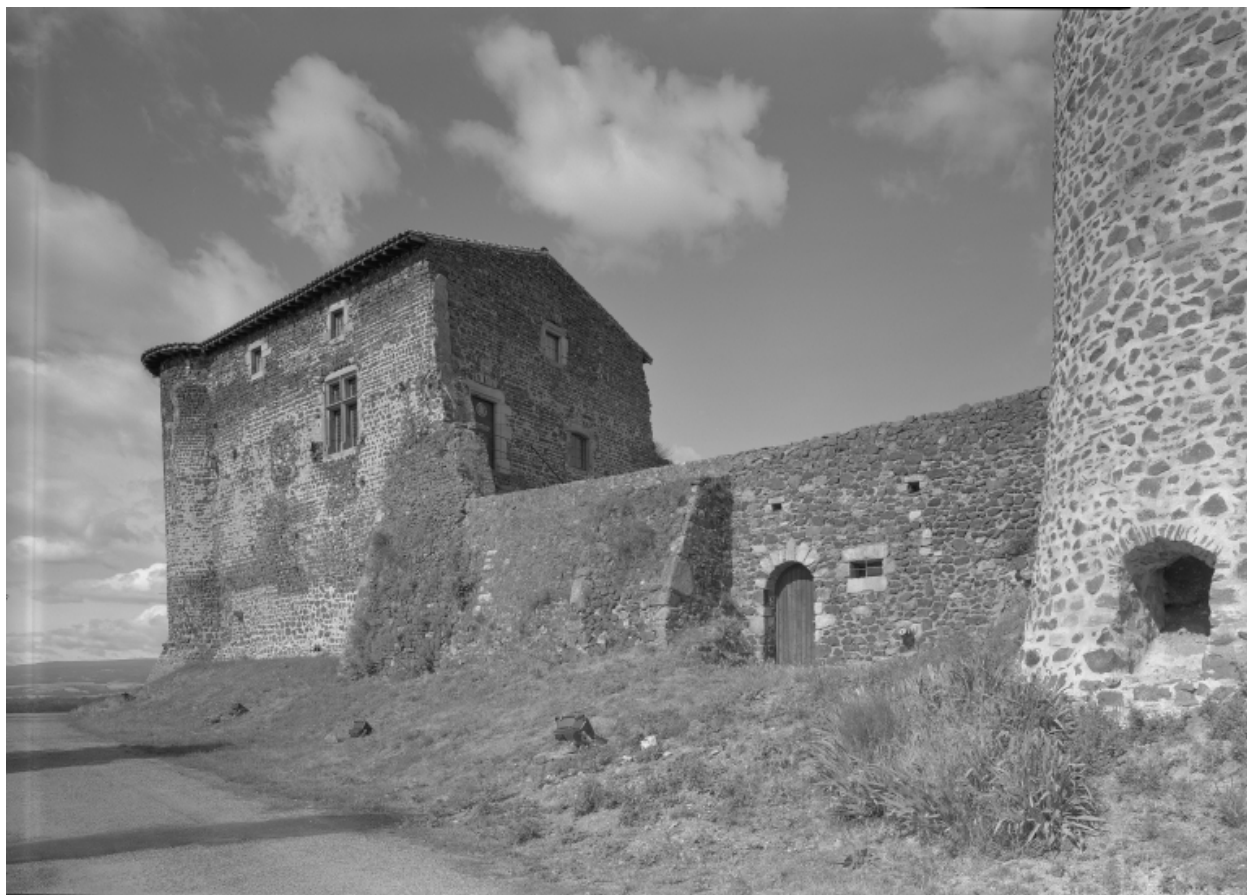
Vue d'ensemble extérieure du bâtiment sud-est, depuis le nord-est.
