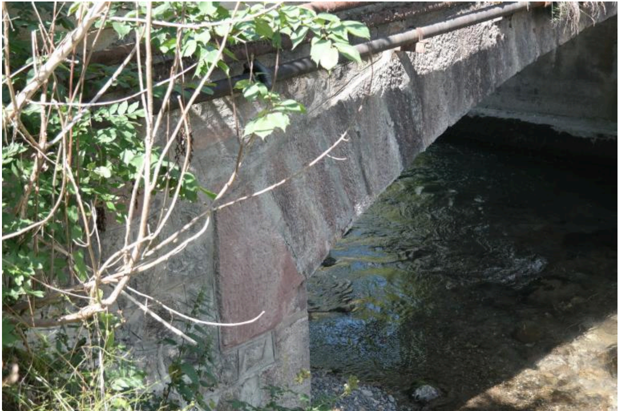
Pont de Chez les Ogays, détail de la voûte
