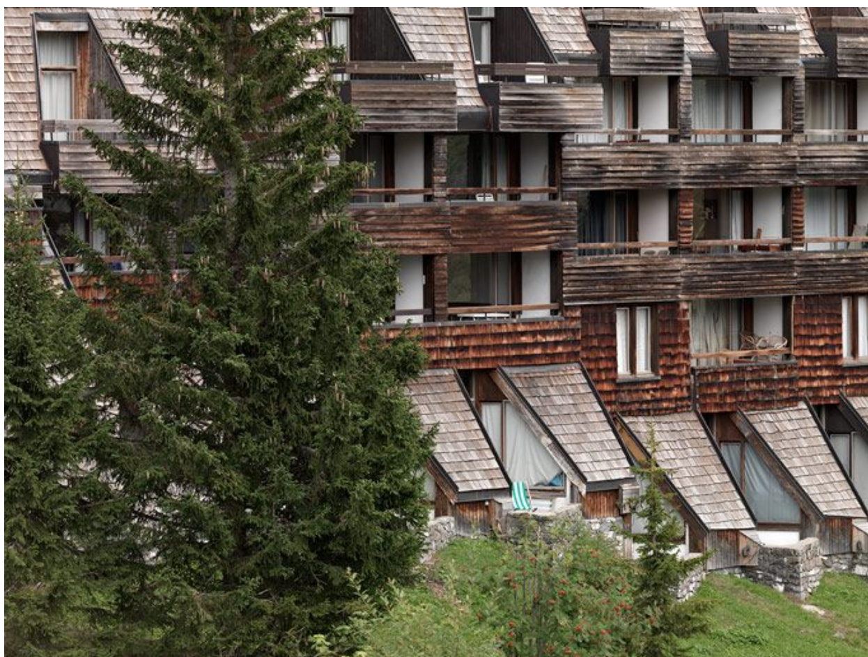
Façade sud. Détail
