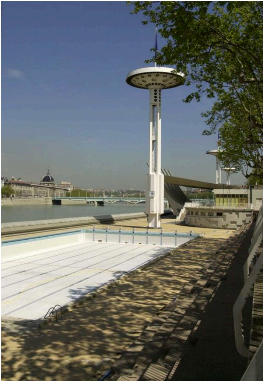
Vue d'un mât d'éclairage et du bassin sud
