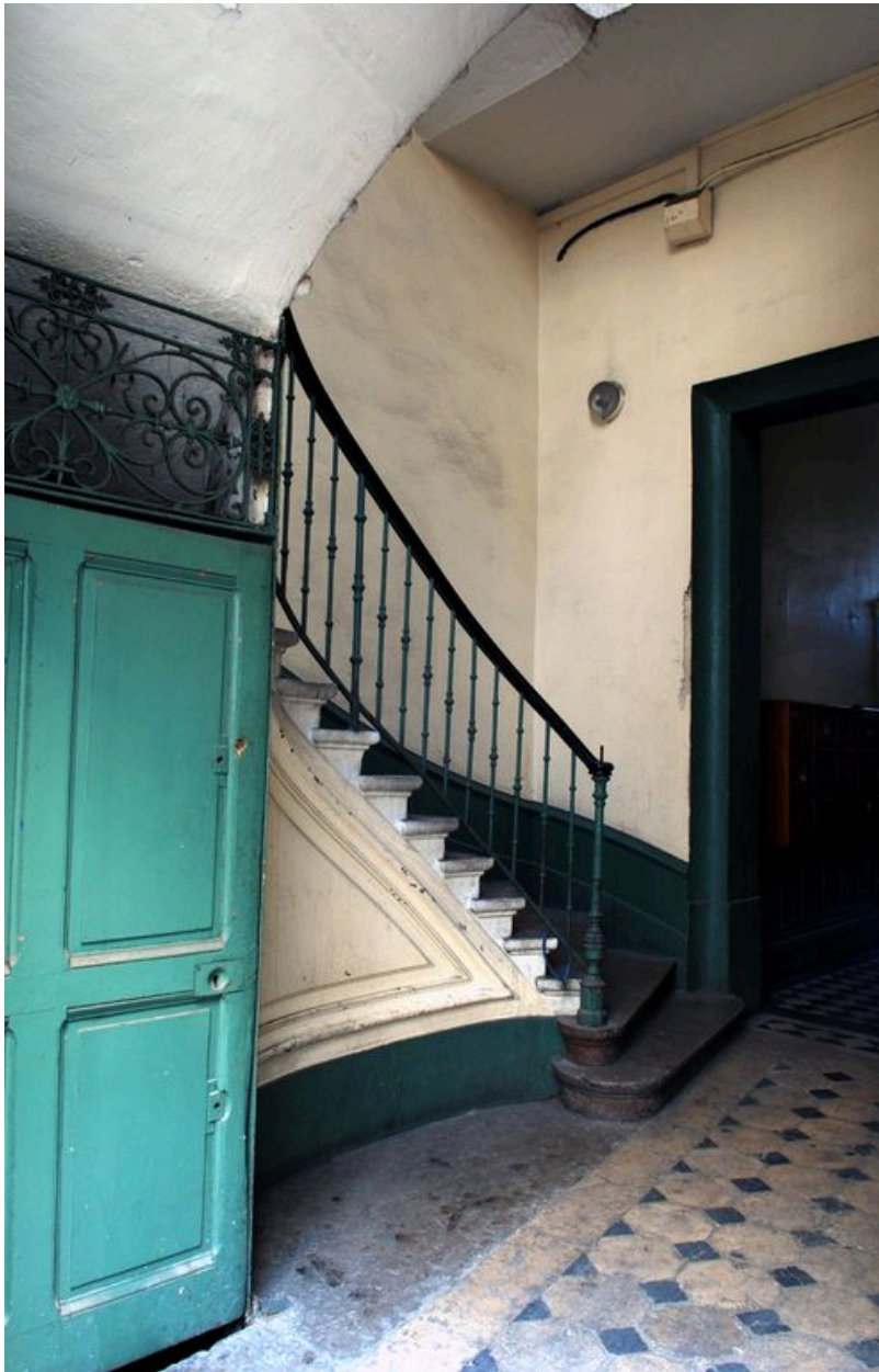
Première volée de l'escalier, depuis la cour
