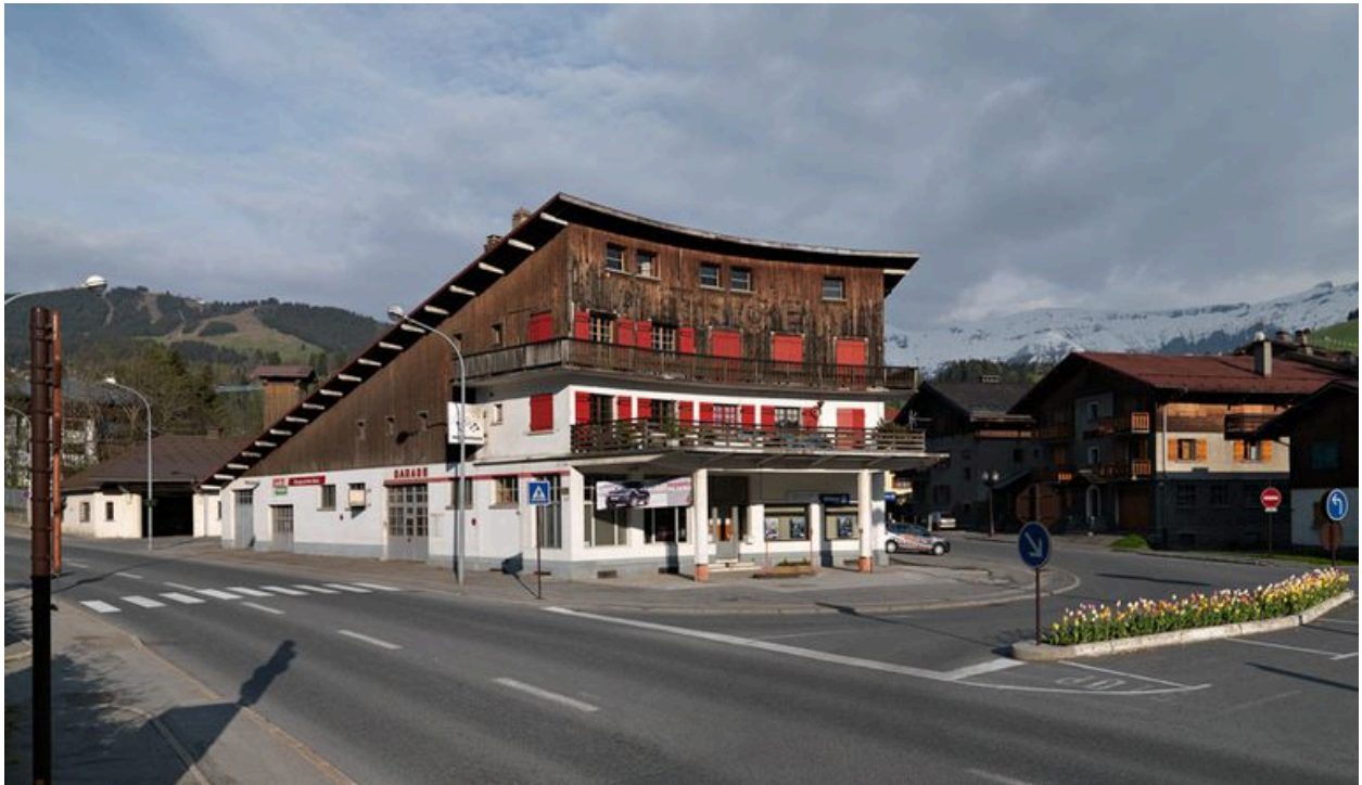
Vue depuis le sud-ouest
