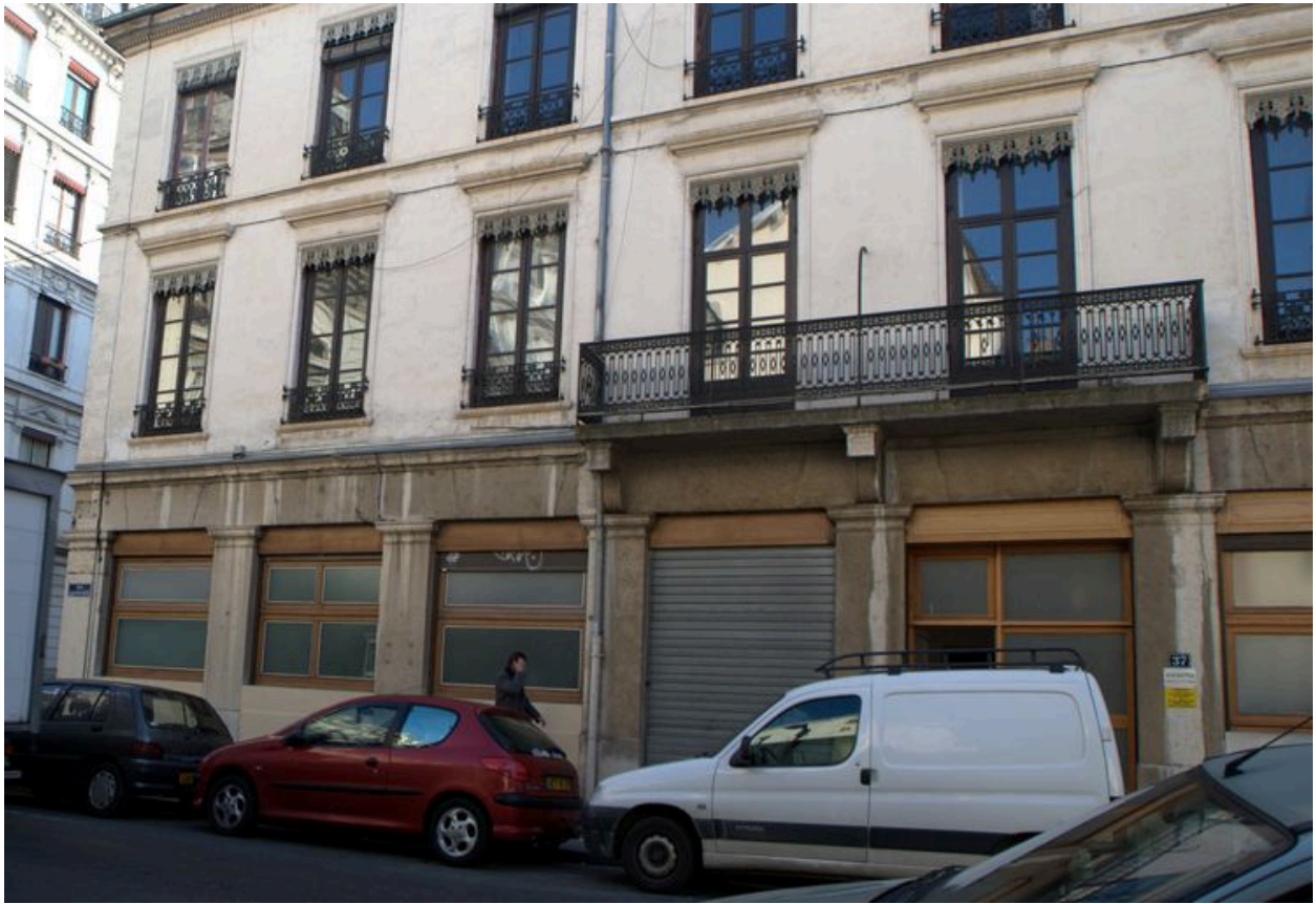
Élévation antérieure du 37 rue Vaubecour, détail des deux premiers niveaux
