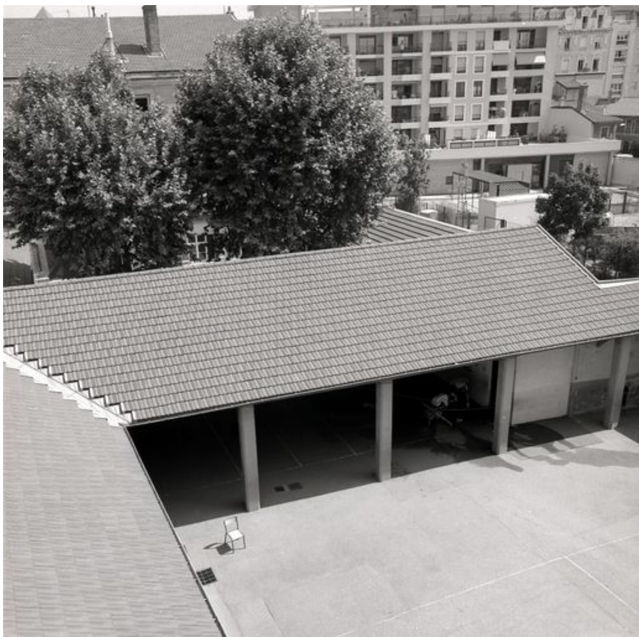
Cour centrale. Vue plongeante depuis l'ouest
