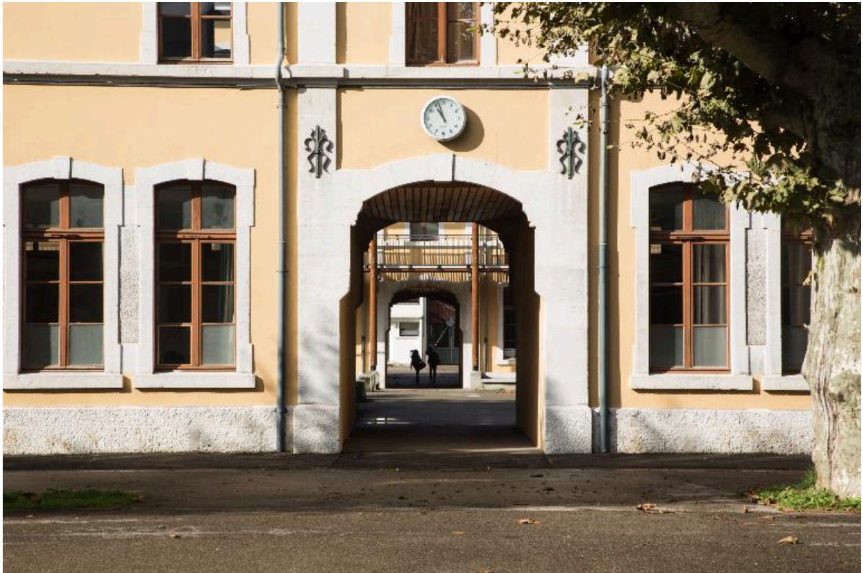
Cour 1 : passage vers cour 2.
