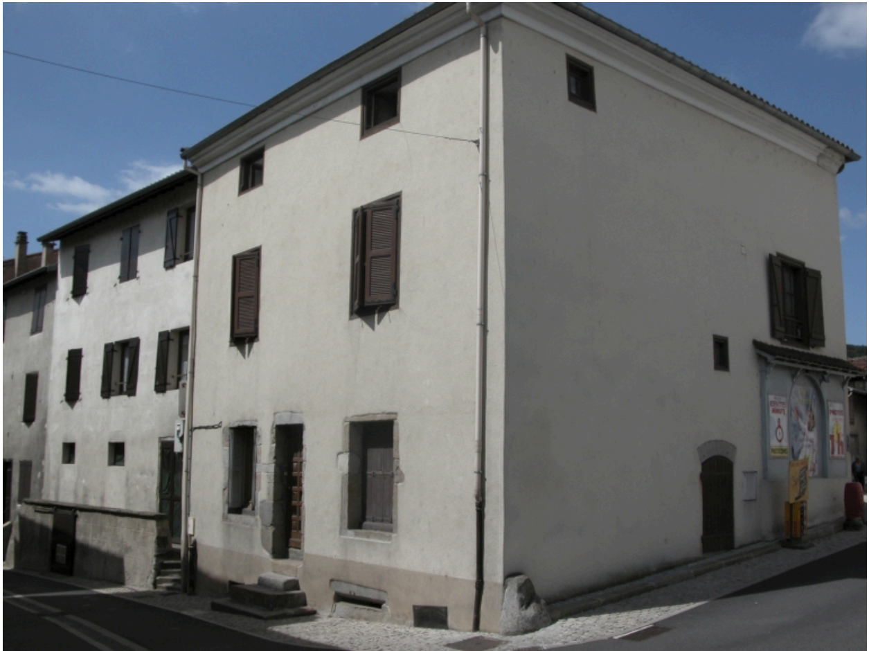
Îlot 1. Roanne (rue de) 10. Vue d'ensemble des façades sur rue.
