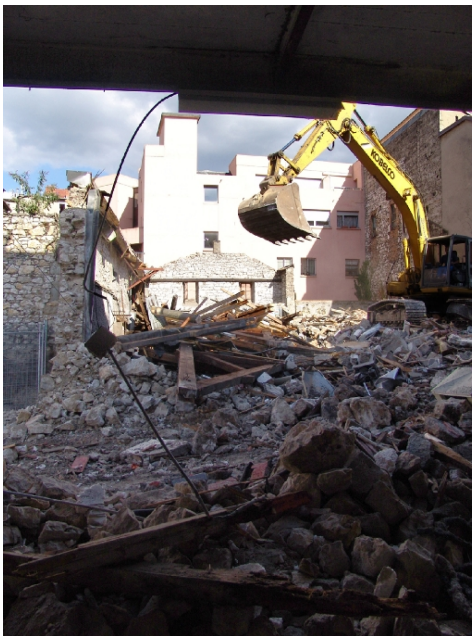
Démolition de la partie arrière
