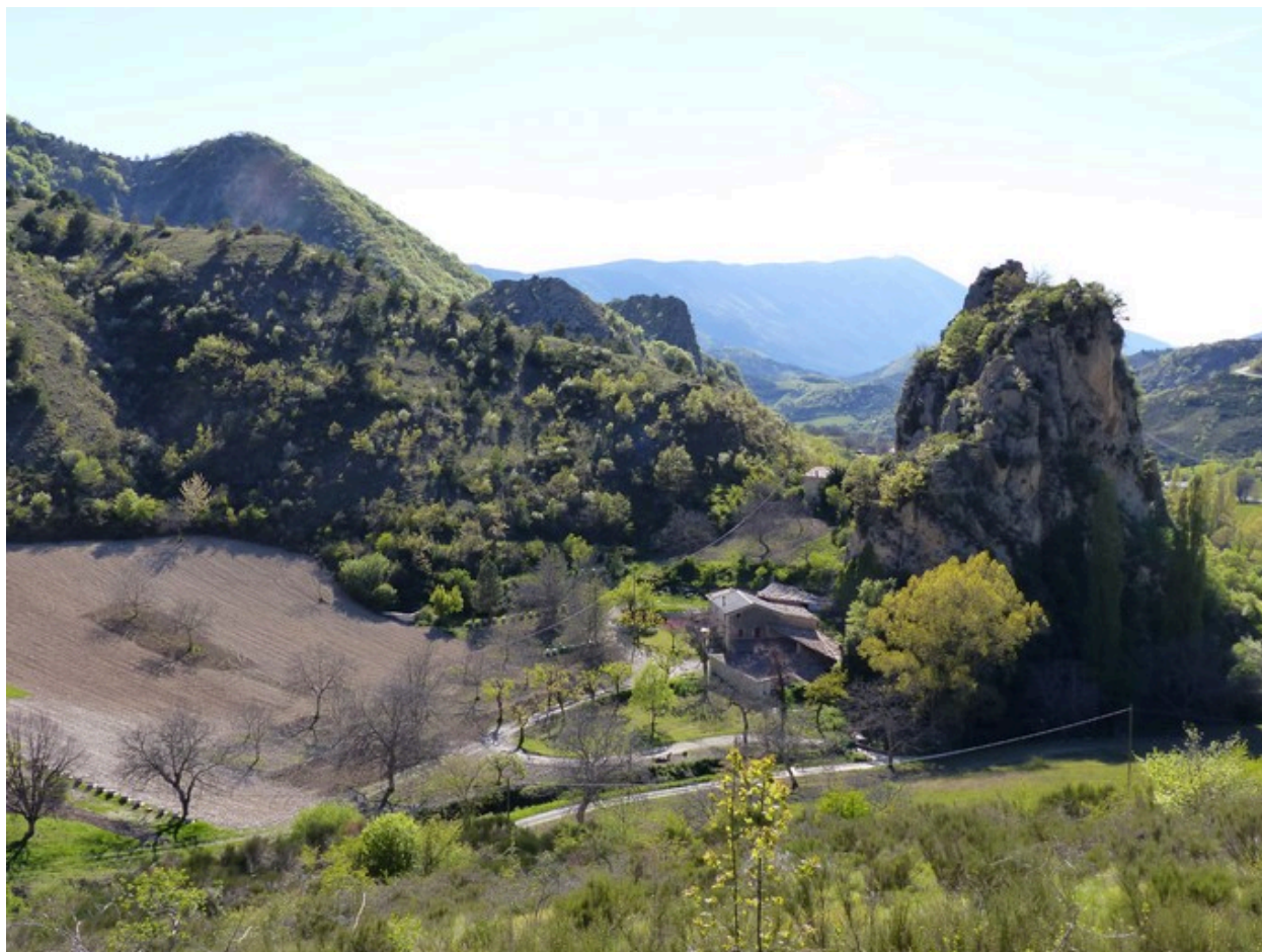
Vue de situation prise du nord-est.
