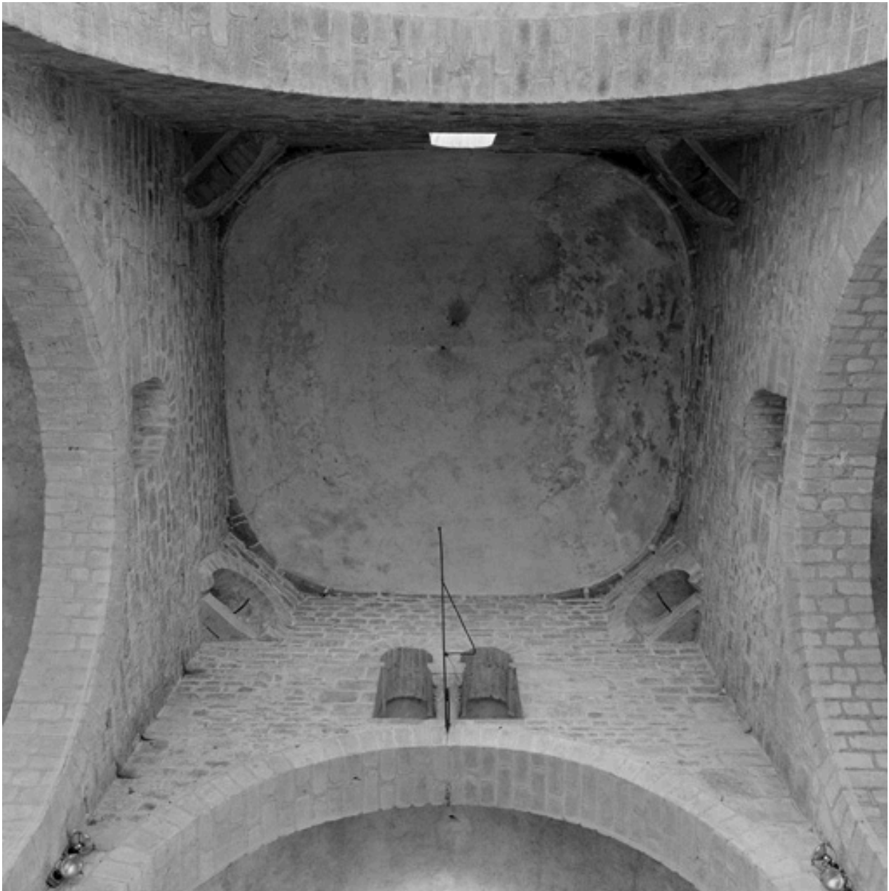
Vue d'ensemble intérieure de la coupole.
