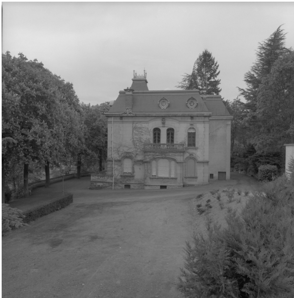
Vue générale de la façade ouest.
