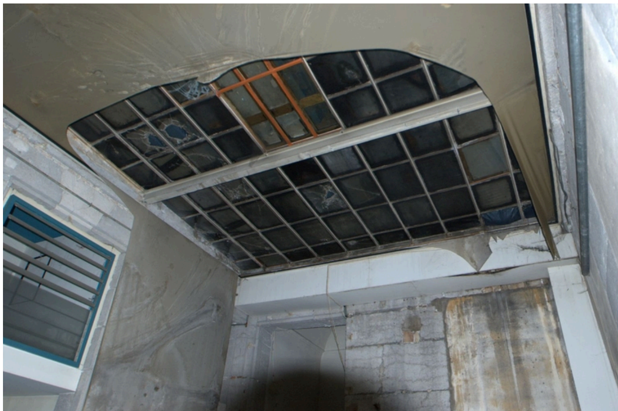
Plaque de verre permettant l'éclairage du sous-sol
