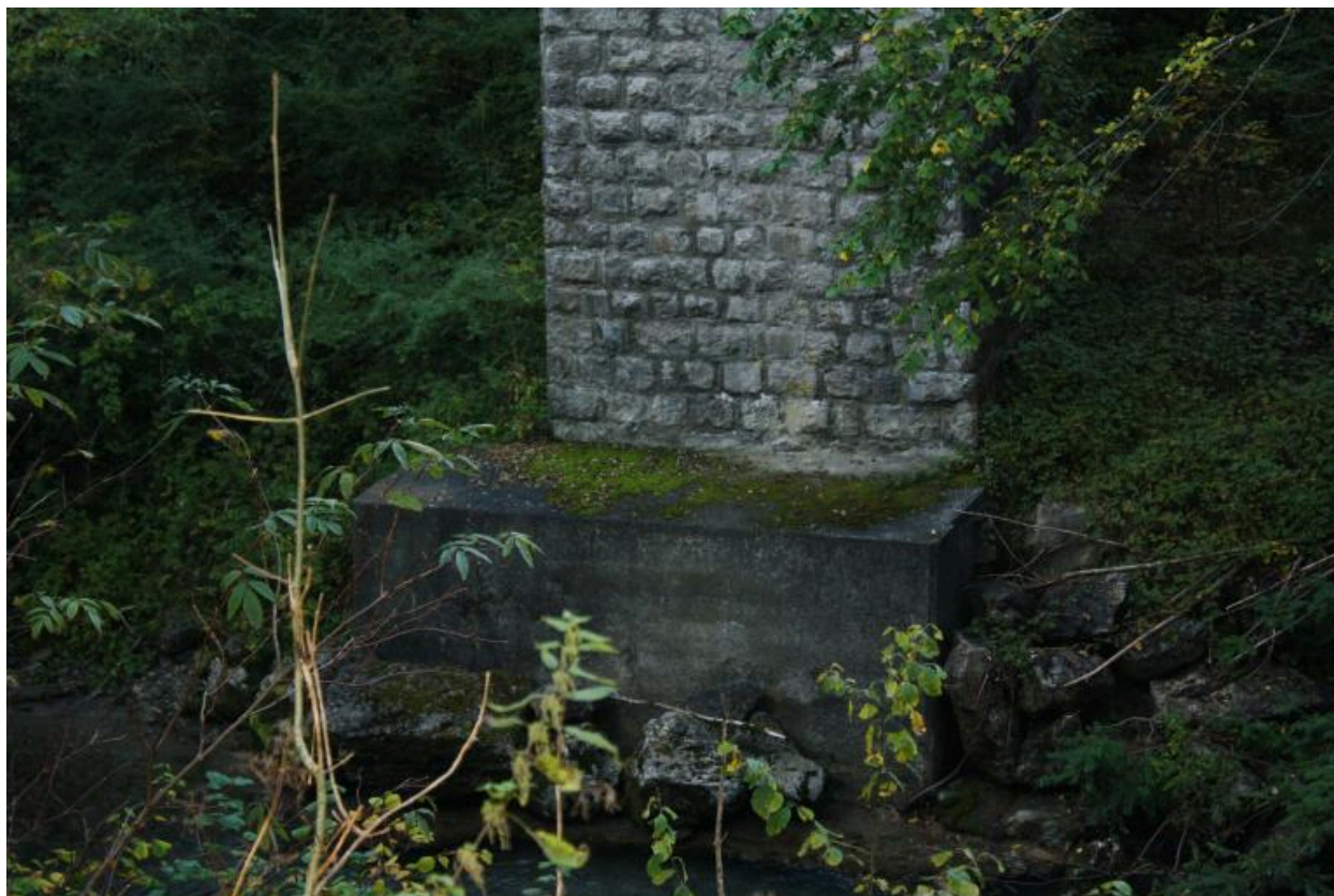
Pont de la Tassonnière, pile et socle
