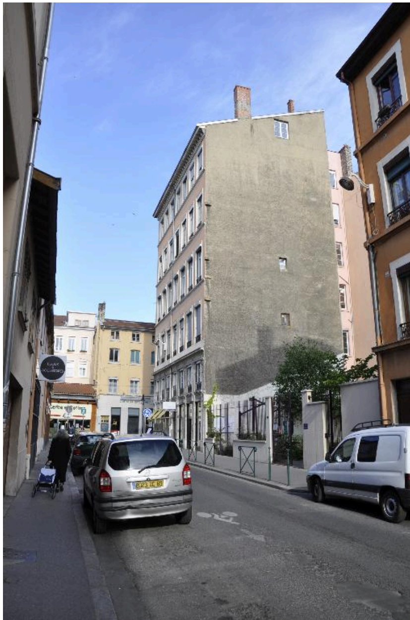
Vue sud est depuis la rue d'Ivry
