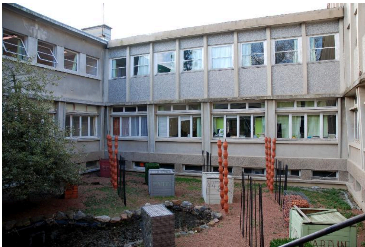
Bâtiment H1 : cour intérieure
