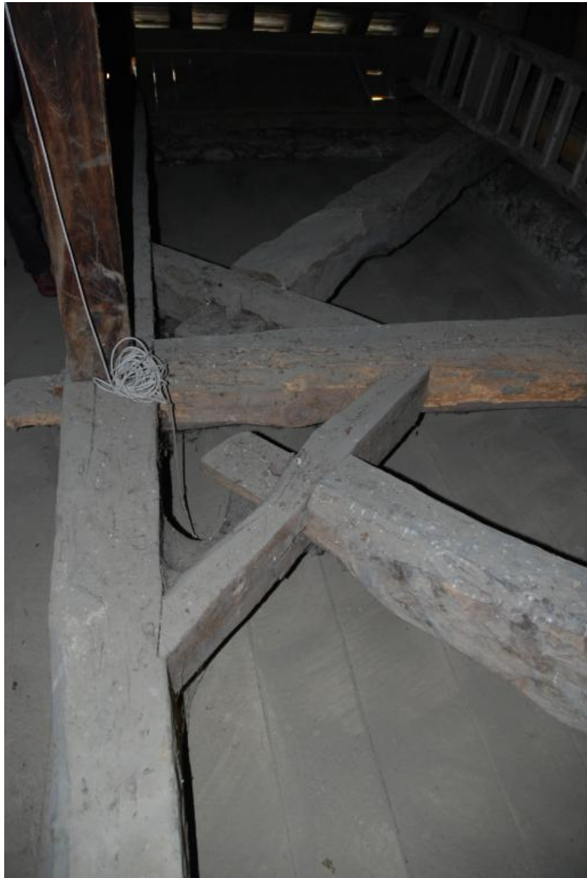
Vue intérieure de la charpente : noe.
