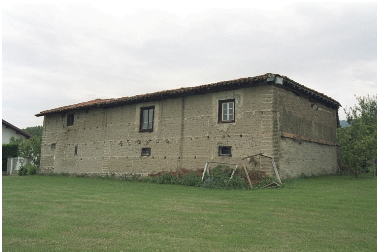
Marcoux, Reigneux, ferme (1986 ZB 136). Vue d'ensemble de la grange-étable en pisé (19e siècle).
