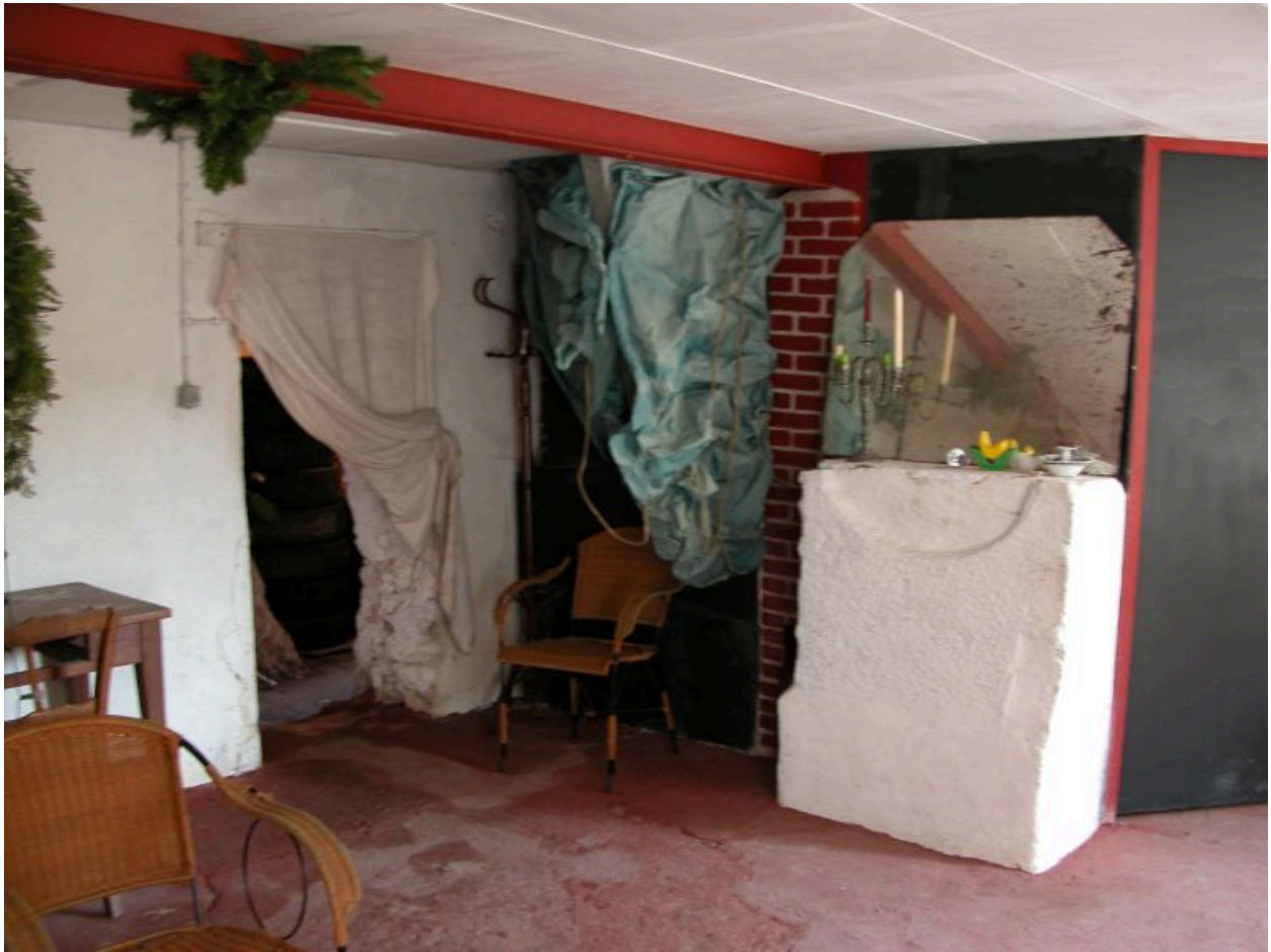
Vue intérieure et partielle du sous-sol où se tenaient les meules à grains.
