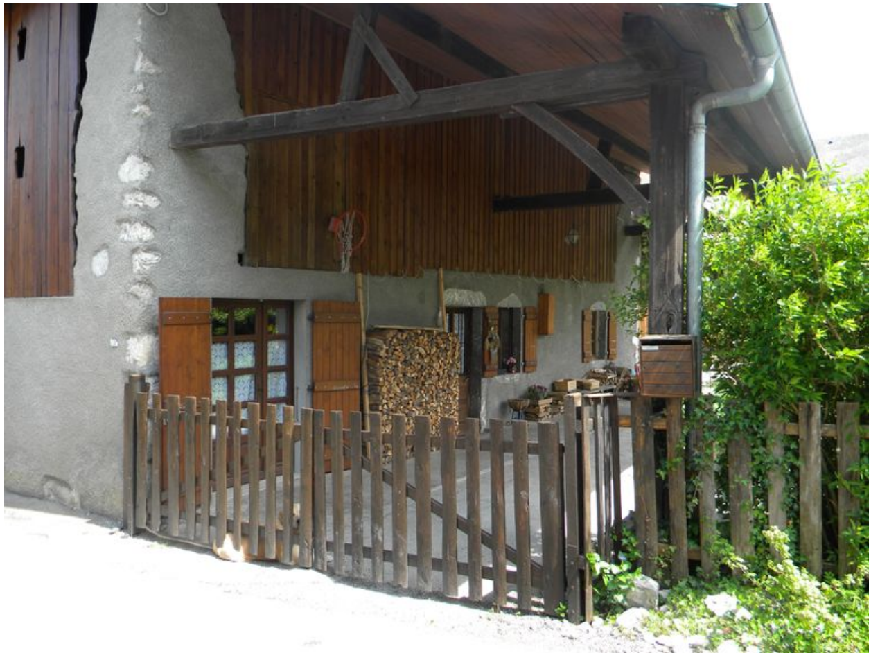
Façade principale d'une ferme (2008 C8 1138)
