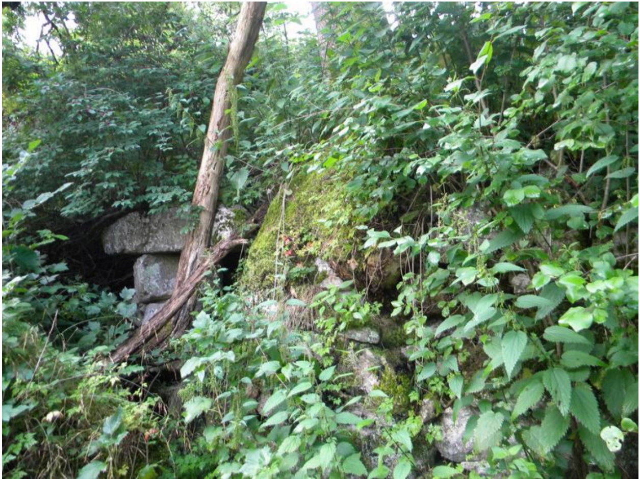
Vue des ruines de l'ancienne scierie du Cruet.
