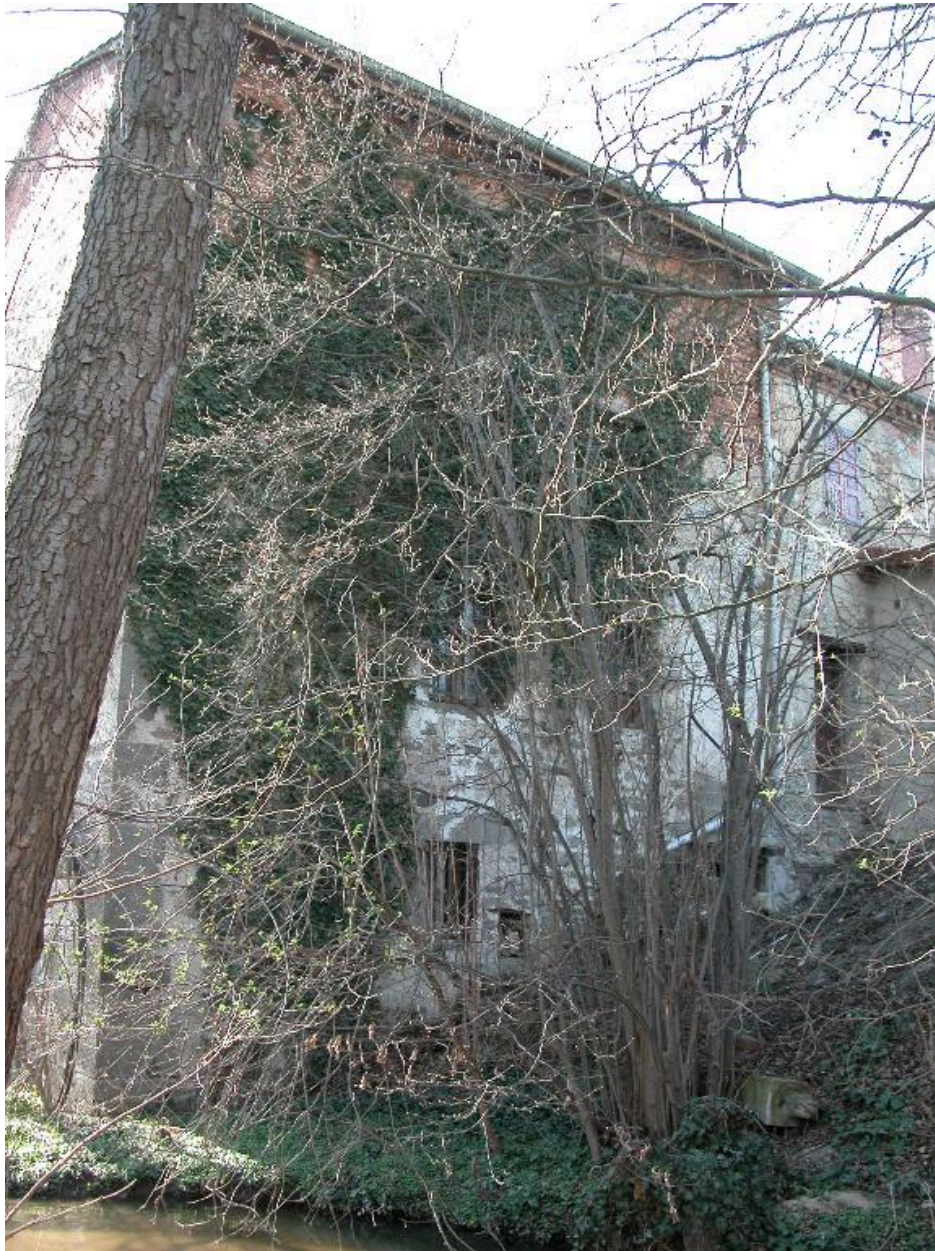
Vue partielle arrière du moulin.
