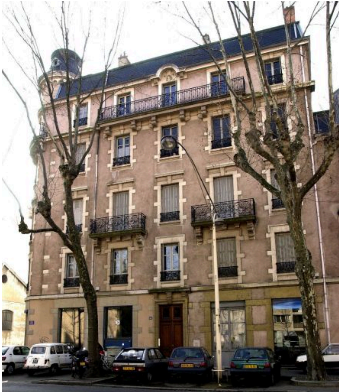
Façade principale, 18 cours Suchet
